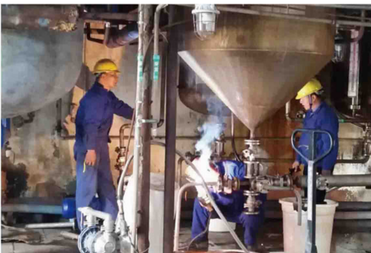
图为检修人员正在对设备进行检修和维护
